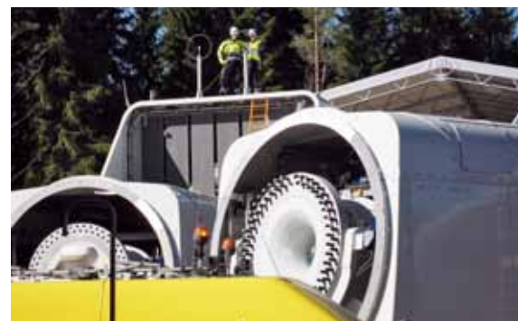
➤ Byggnation av vindkraftparken Jädraås, 66 vindkraftverk.
