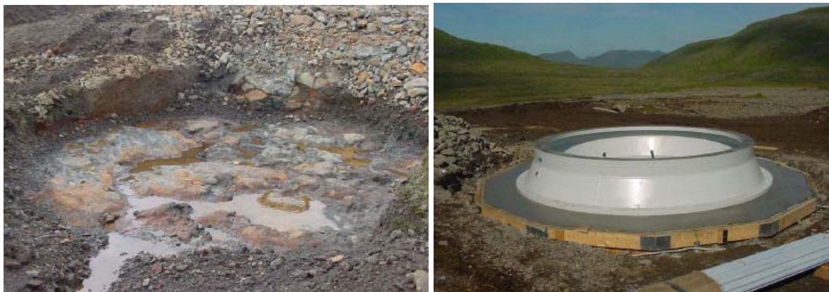
Figur 12. Bilder på byggnation av bergsfundament
