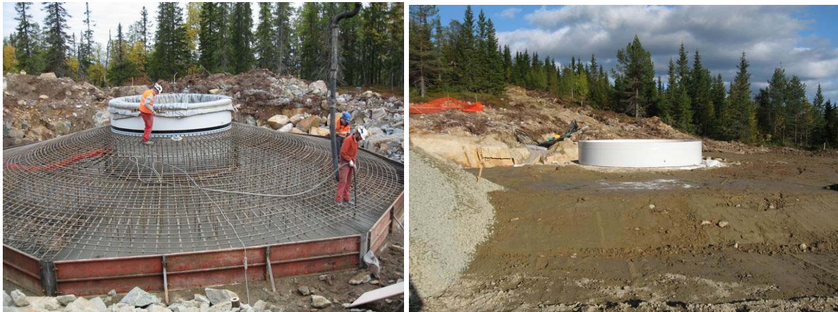
Figur 10. Bilder på uppförande av gravitationsfundament
